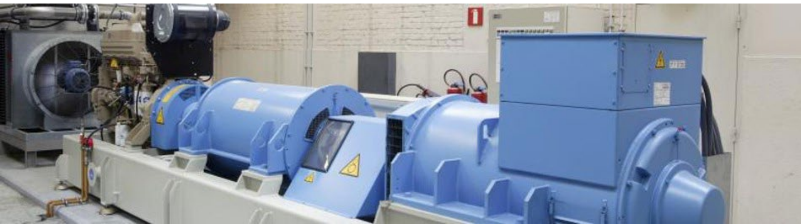
(Photo 3 - Système ASI dynamique Luminus Solutions)
