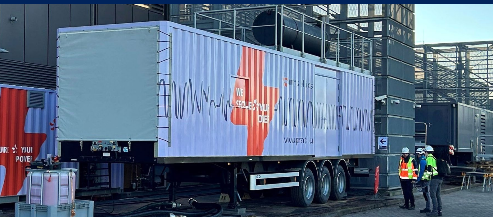
(Photo 7 - système ASI mobile Luminus Solutions)
